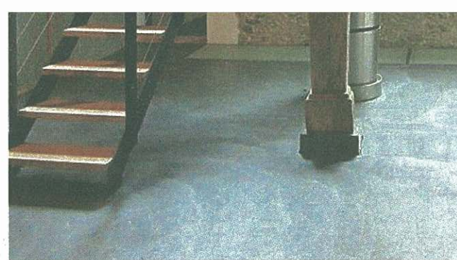
Der Einbau einer modernen Treppe wurde als gelungen beurteilt.
